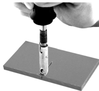
Fixieren der Flanken mit der Schweißspitze in Abständen von etwa 2-5 mm.
