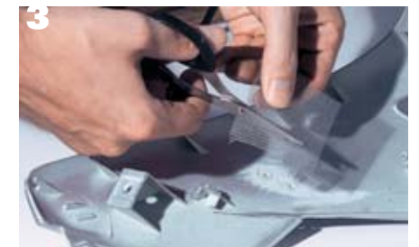
Armierungsgewebe wird zugeschnitten. Das Drahtgeflecht verstärkt die Reparaturstelle.
