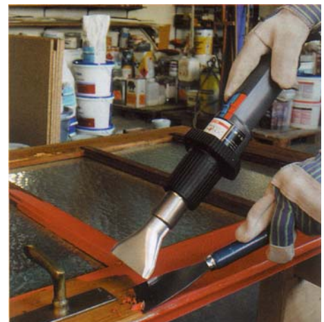
Farbe entfernen / Stripping paint
