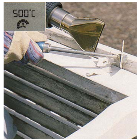
Farbe entfernen / Stripping paint
